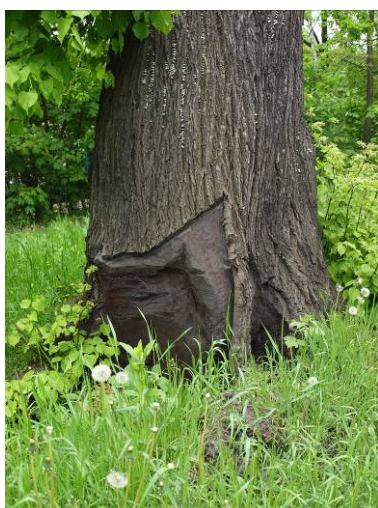
Fot. 4: Martwa lipa, uszkodzony odziomek
