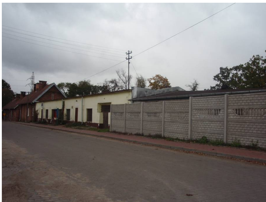
Fot. 4. Zabudowa w rejonie przyszłego skrzyżowania planowanej trasy z ul. Królewską – prawdopodobne przecięcie trasy na wysokości murowanego ogrodzenia.
