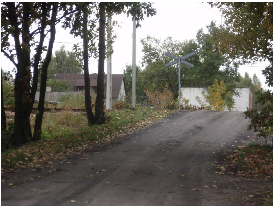
Fot. 8. Rejon przejazdu przez tory linii WKD – widoczne podniesienie niwelety torów kolejowych ponad linię terenu.
