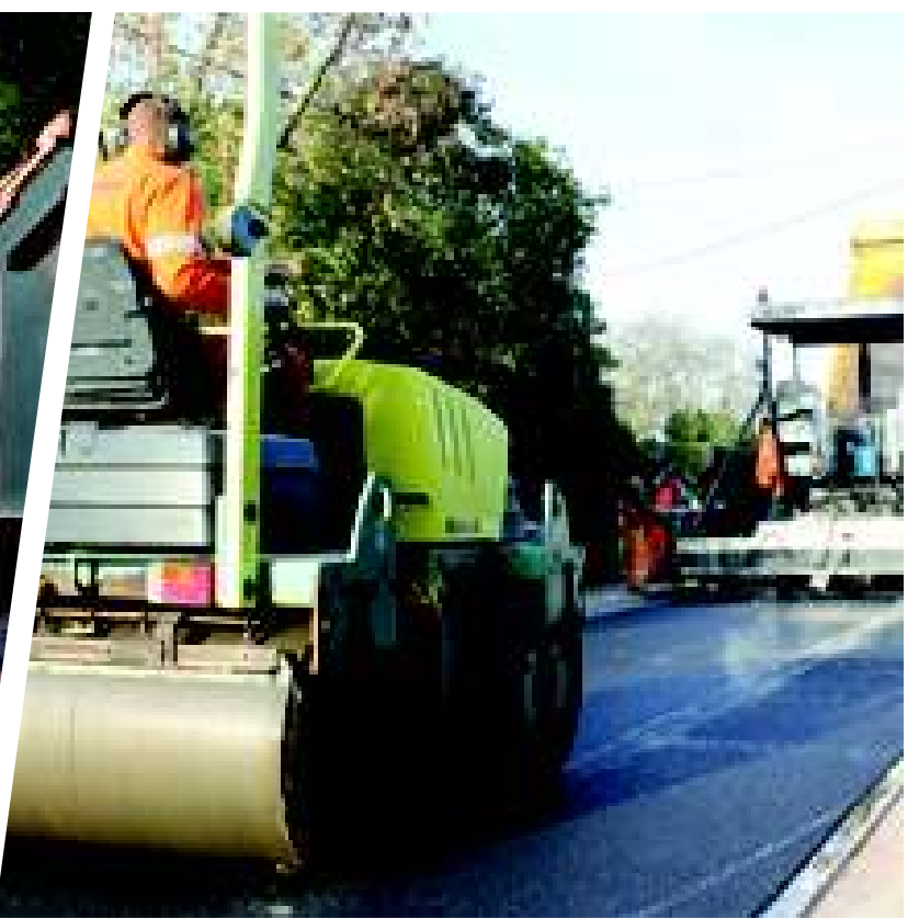
Przebudowa ul. Gospodarskiej
