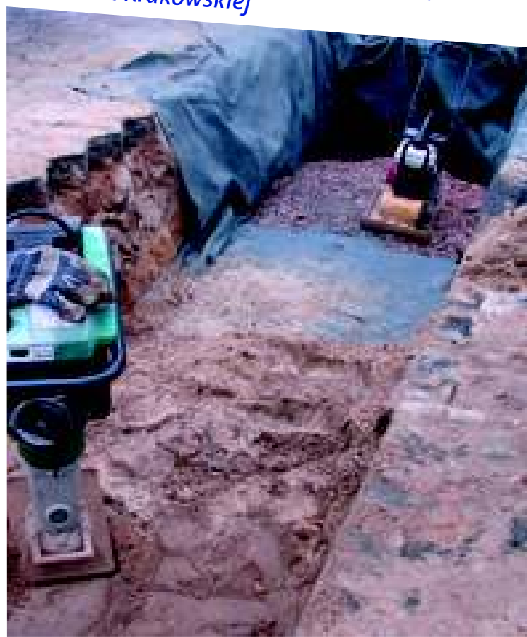
Zakończenie budowy odwodnienia w ul. Krakowskiej
