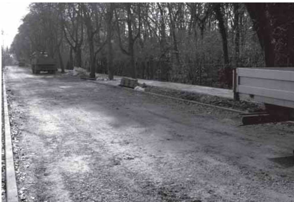
Budowa ul. Zachodniej na odcinku Słowackiego - Wielki Kąt
