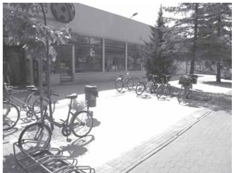
Wyremontowany chodnik przy sklepie Biedronka
