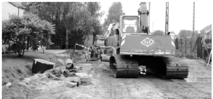
Budowa kanalizacji na Osiedlu „Gospodarska”
