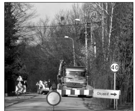
Realizacja Kanalizacji przy Wojska Polskiego
