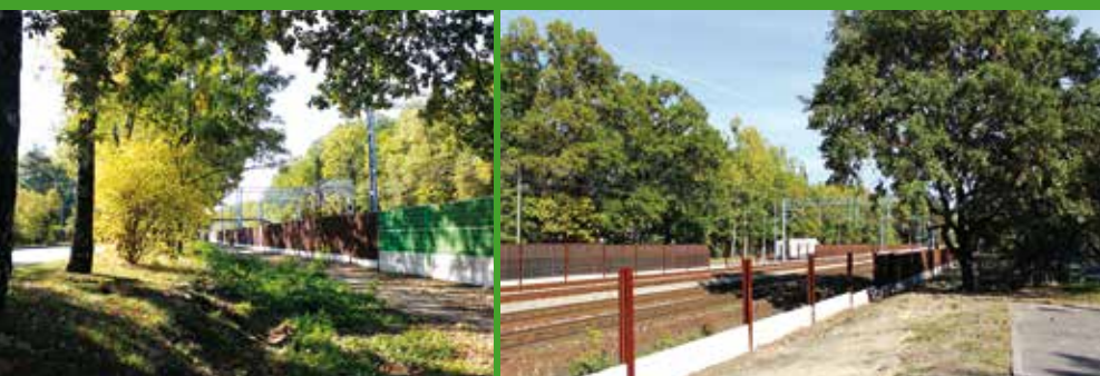
Ekran akustyczny w centrum Milanówka
